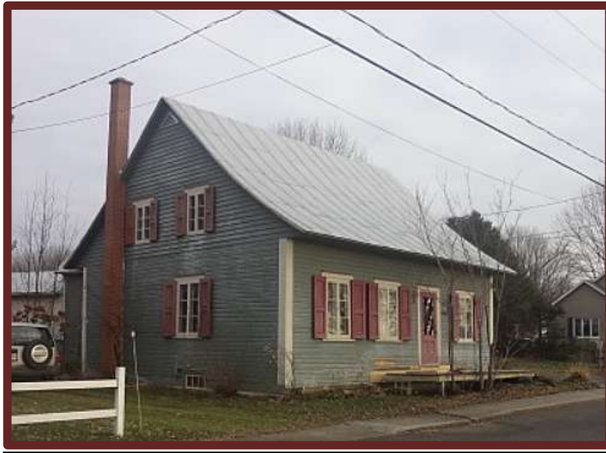
Ci-dessus maison Deschenaux du lot 26c . Photo 2015 (travaux en cours d'entretien du perron).
